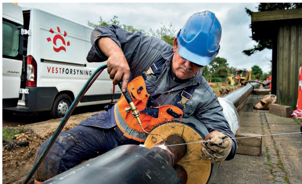
Udbygning af fjernvarmenettet i Vestjylland. Foto Jens Bach
